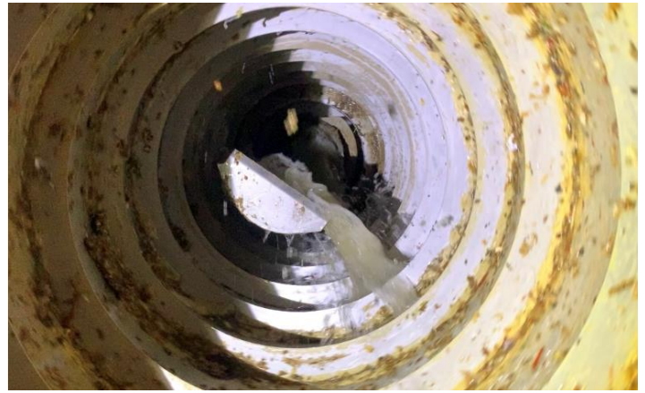
vue de l'effluent arrivant dans le tambour
